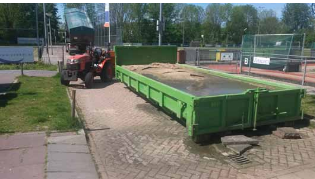
Afvoer naar een container buiten het veld.
